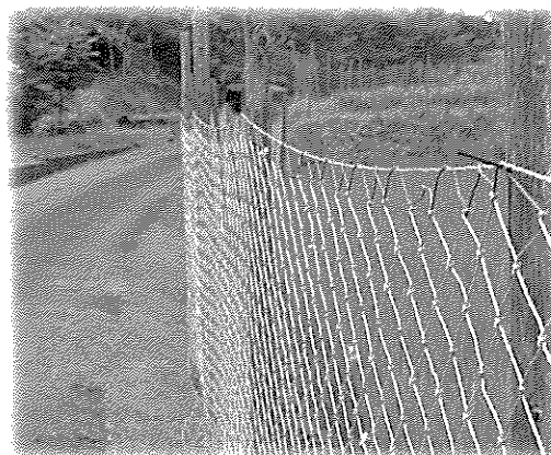
図3 獣害対策のための柵が設置されている
