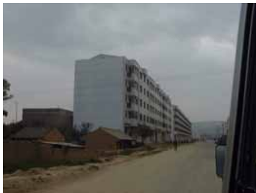
写真1 完成した集合住宅と取り壊し間近の住宅 (水洛鎮北城区)
